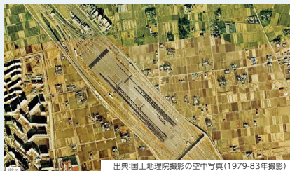
開発前(武蔵野操車場)
